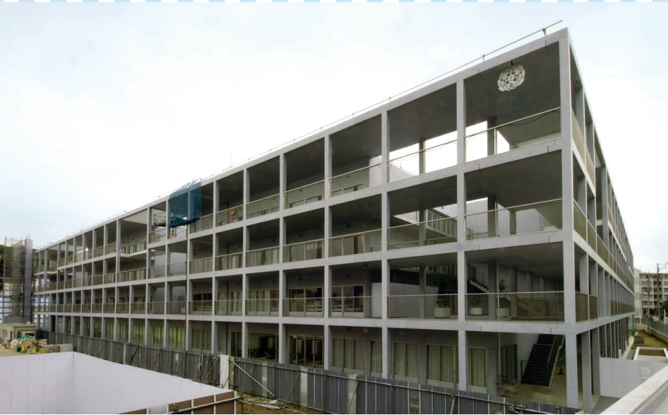
まだ一部工事中。奥行き4mの広いテラスがこの小学校の最大の特徴である
