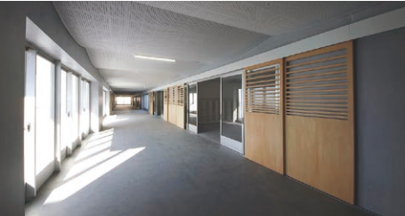
幅4mの廊下に面して教室が並ぶ。教室の建具は二重になっている
