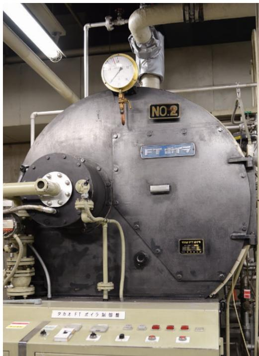
「蒸気機関車？」と見紛うような巨大な煙管ボイラーが3台。1日最大10～11トン相当の蒸気を発生させ、暖房と冷房に利用します。
