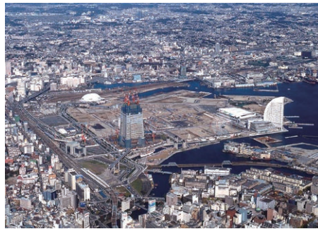
建設中のランドマークタワー 1991年11月 横浜市史資料室所蔵資料
