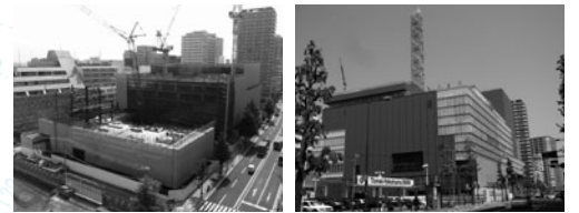
躯体工事中(2009年5月)
