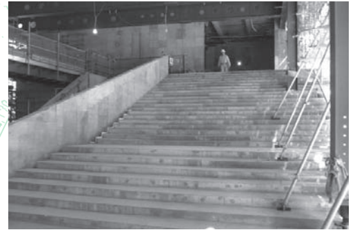
建設中の神奈川芸術劇場、アトリウム大階段(2009年10月)
